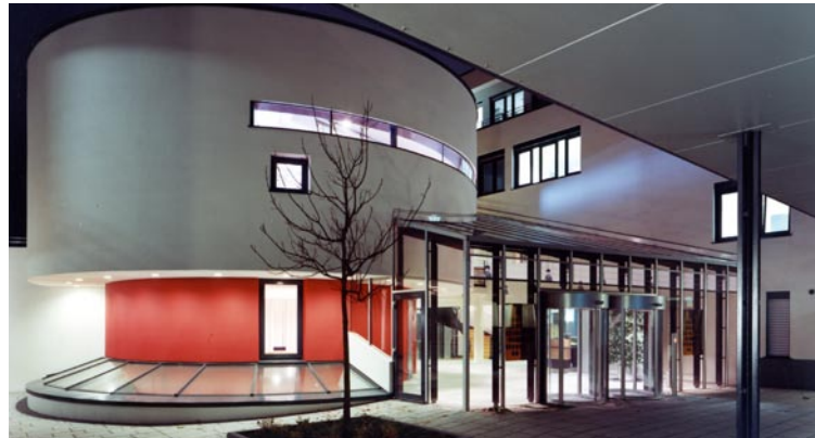
Haus der Architekten Stuttgart
