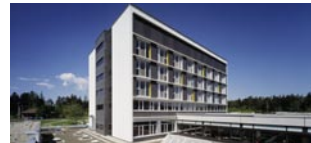
Fassade Hochhaus nach der Sanierung
